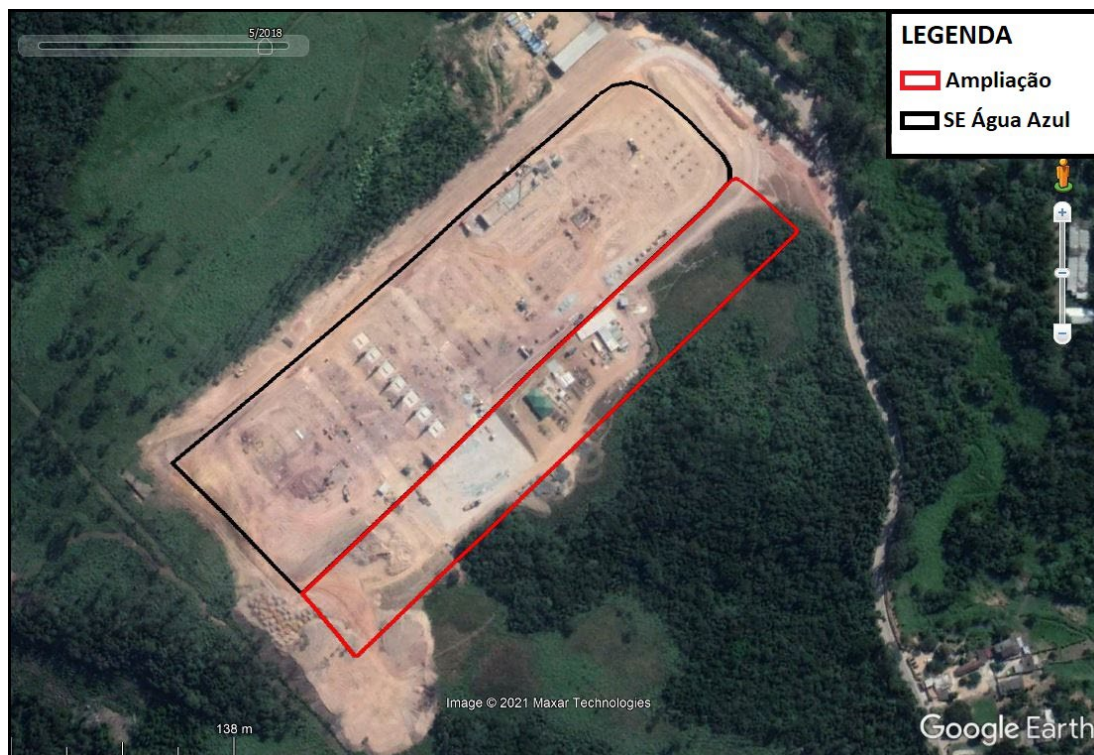
Figura 18 - Canteiro de Obras de SE Água Azul em 20 de maio de 2018 (Fonte: Google Earth Pro, 2021)
